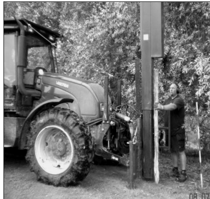
Hegnspælene bankes i jorden for hver 2 meter.
